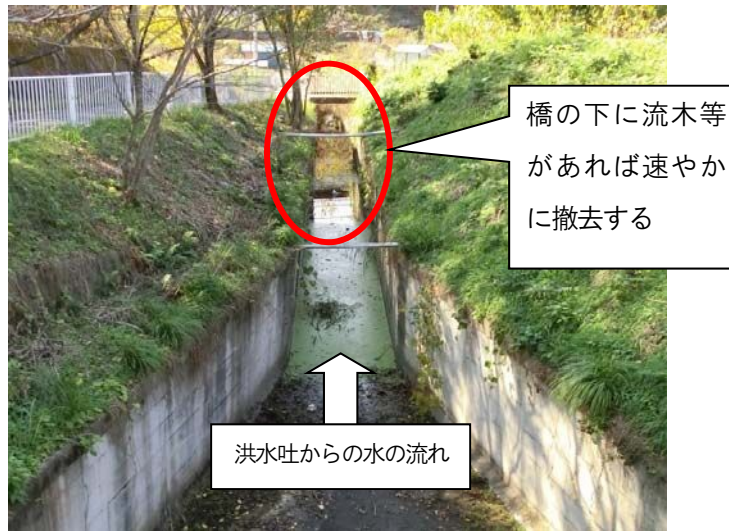
写真8：洪水吐下流水路の例
