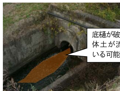
写真11：底樋出口（堤体下流）
