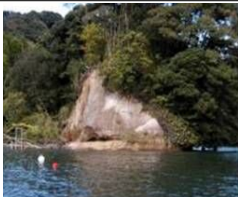
写真 36：ため池斜面の崩落
