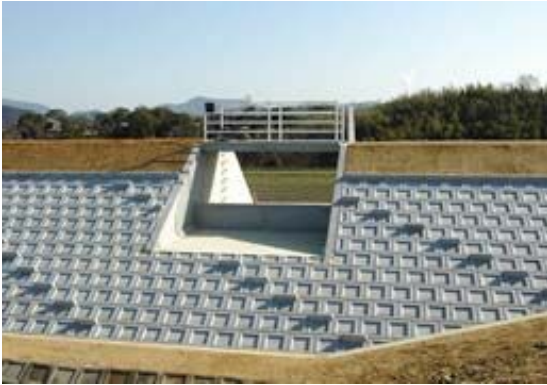
写真1：洪水吐 (香川県HPより)
