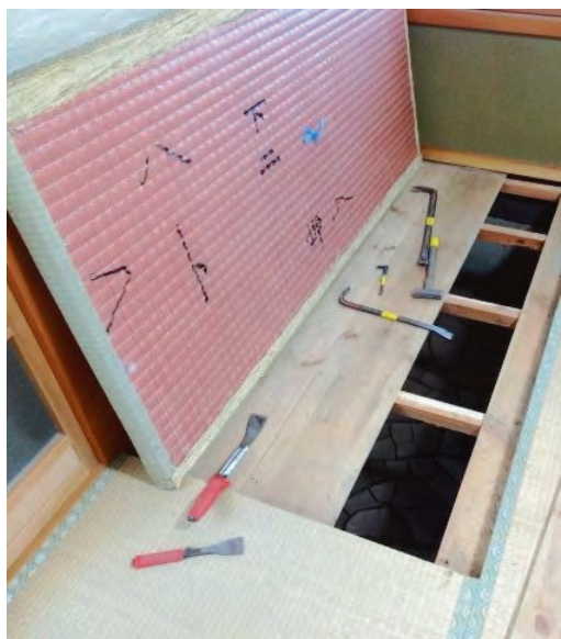
和室の床板をはがす（写真①）
