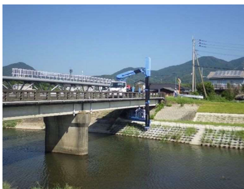
橋梁点検車による定期点検
