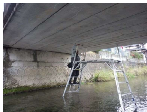
定期点検（打音検査）状況
