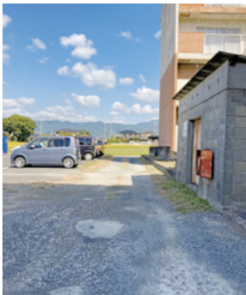
町道の未舗装道路
