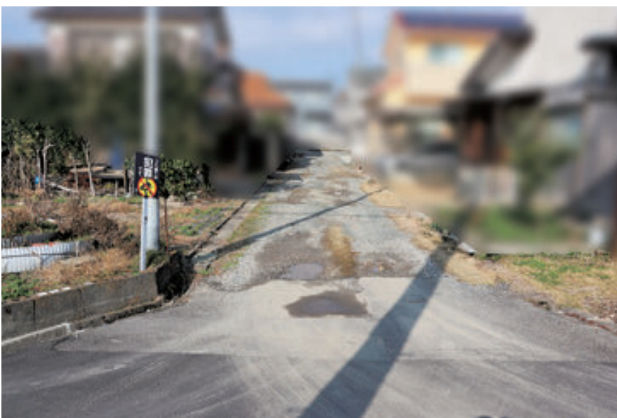
住宅地内の未整備道路
