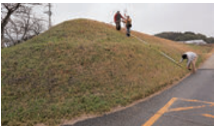
こう配がきつい法面
