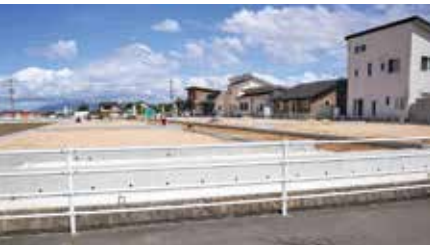
坊所処理区内の宅地造成
