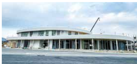
建設中の道の駅
