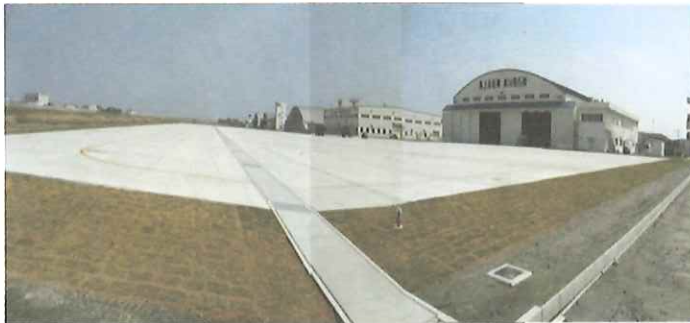
駐機場・格納庫（北徳島駐屯地）
