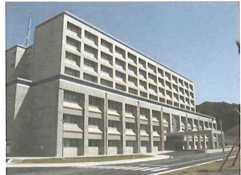
隊庁舎（高知駐屯地）
