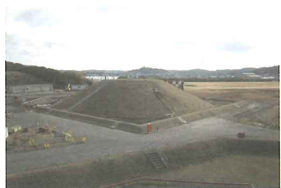
燃料タンク（館山航空基地）
