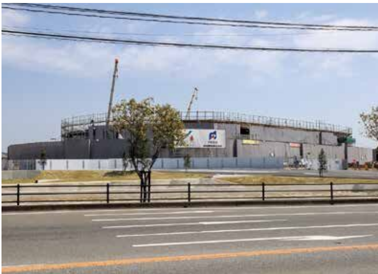
定住促進住宅建設中
