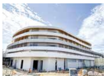
建設中の定住促進住宅
