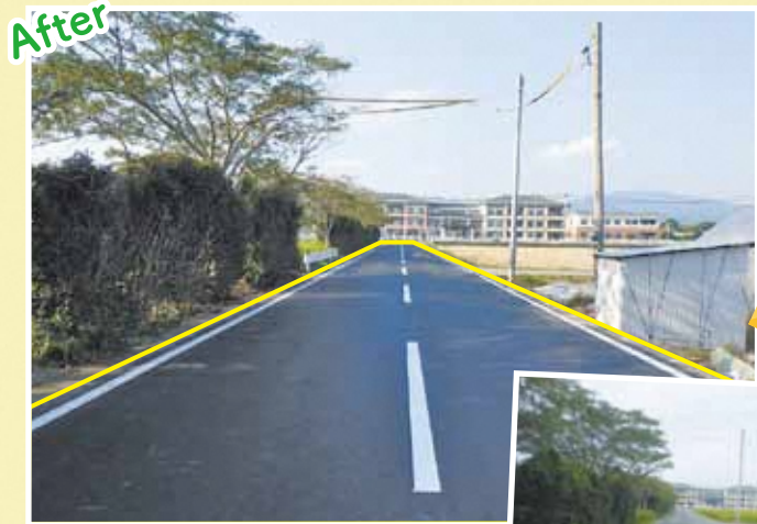
平成29年度 特定防衛施設周辺整備調整交付金 町道八枚坊所新村線外1改良工事
