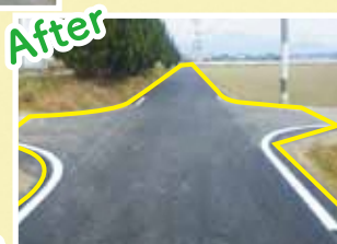
平成29年度 町道坊所九丁分線舗装工事
