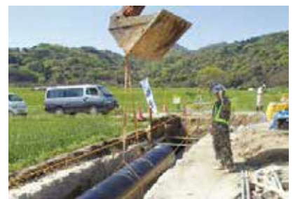
パイプラインの施工状況
