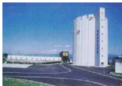
佐賀揚水機場 (関連事業)
