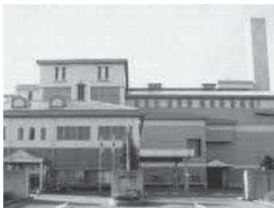
広域ゴミ処理場
