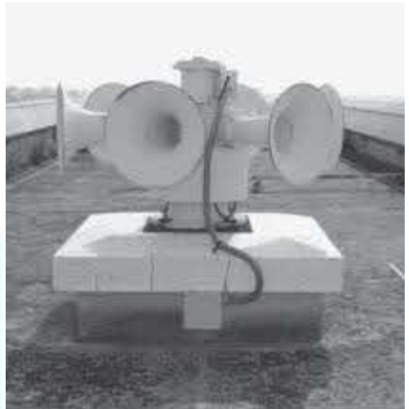
役場屋上サイレン
