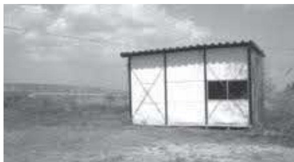
水防倉庫（九丁分）
