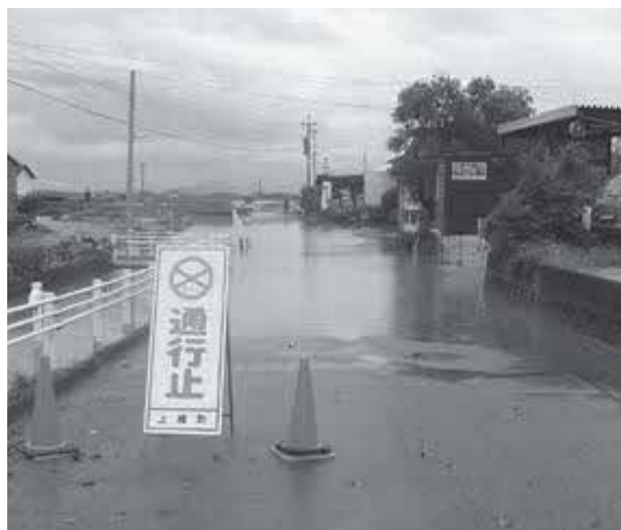
7月の大雨による被害状況
