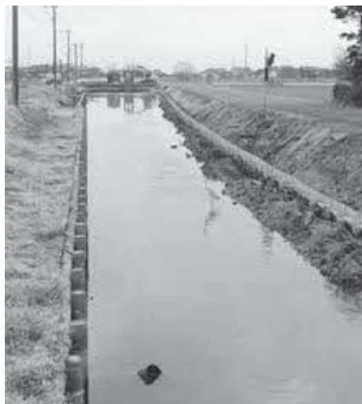
工事中の勘太郎川
