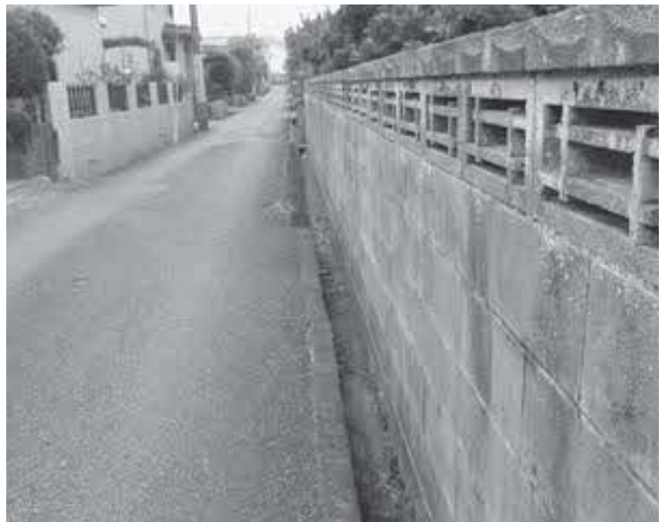
下津毛団地内の道路
