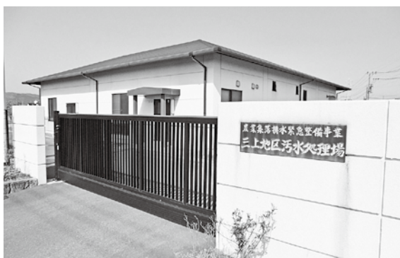
三上地区污水处理場
