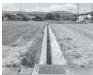
西峰地区の排水路
