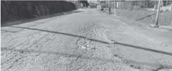
老朽化した路面
