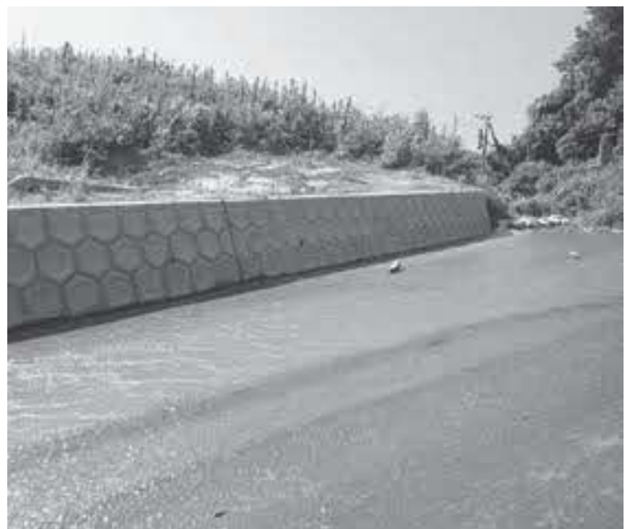
復旧した耕地整理ため池の余水吐
