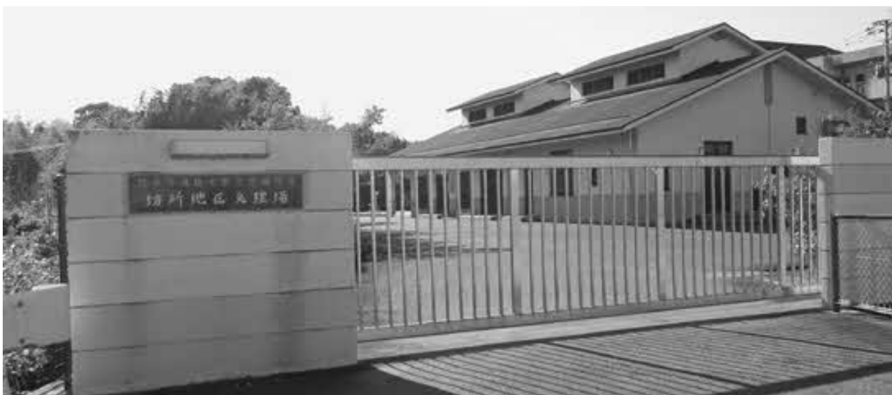
坊所地区汚水処理施設
