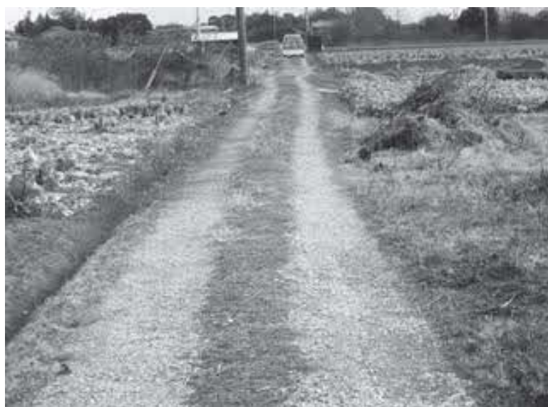
道路整備が必要な道路（三上地区）
