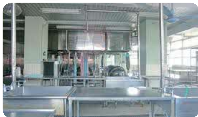
▲休止中の給食センター内部
