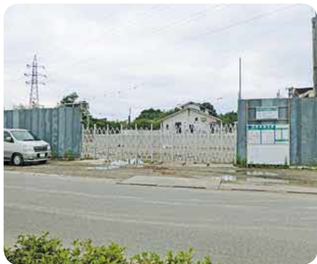
▲工事中の坊所地区汚水処理施設
