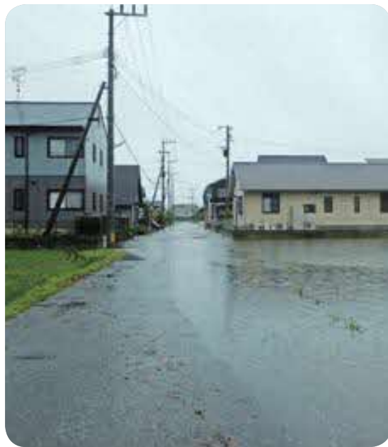
大雨時の冠水状況（中学校東）
