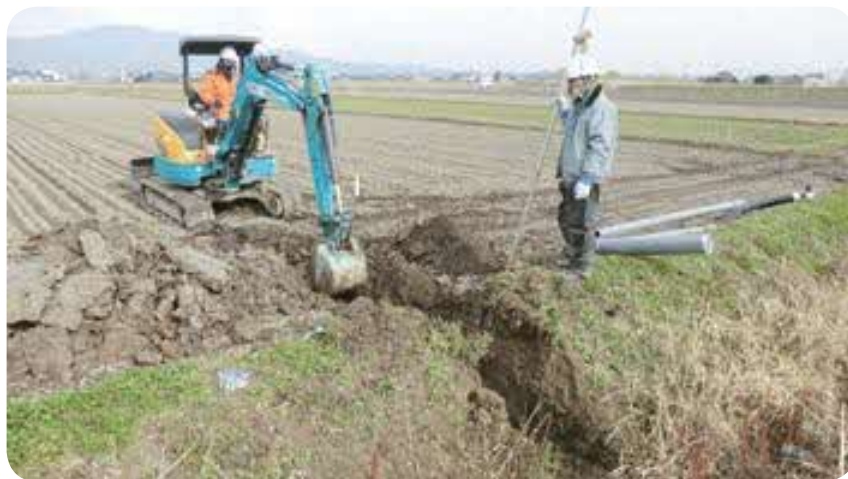
新地下水水位制御システム（フォアス）の施工
