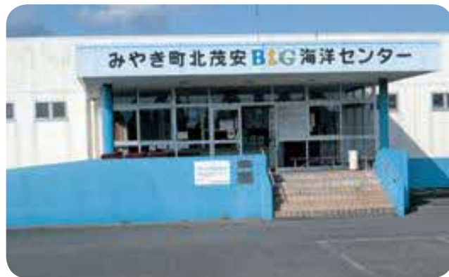
みやき町温水プール
