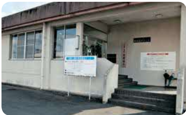
吉野ヶ里町温水プール
