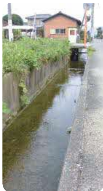
安全対策が必要な水路
