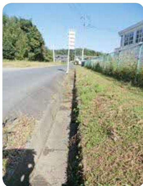
中学校体育館北側の側溝
