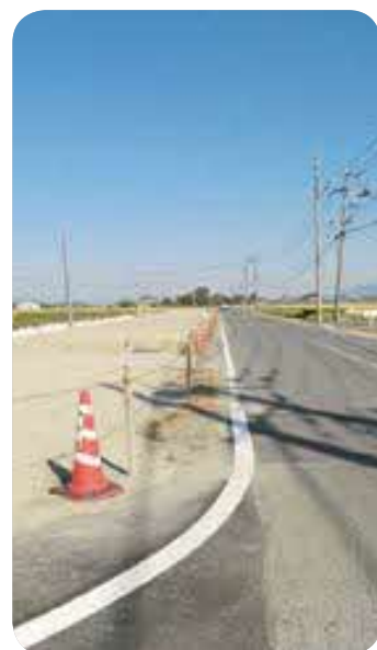
工事中の県道神埼北茂安線
