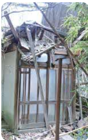
町内の空き家
