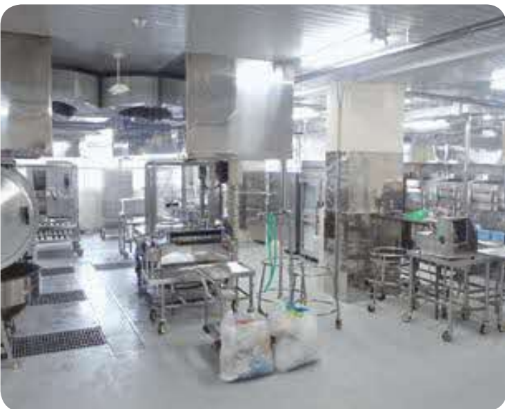
改修中の給食センター（小学校給食室）
