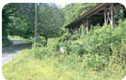
鎮西山施設周辺
