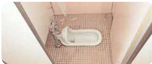
小学校南校舎のトイレ
