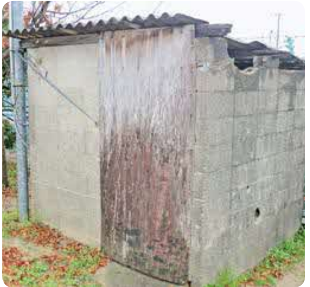
小学校大プール旧ポンプ小屋
