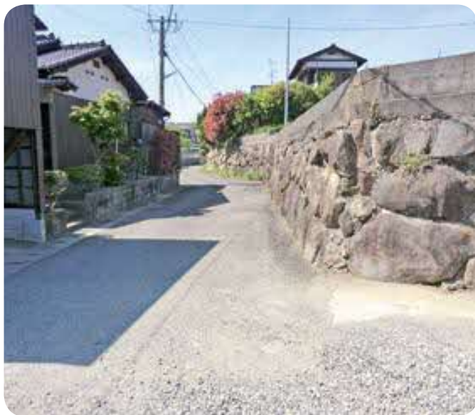
中の尾団地側溝改修
