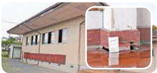
老朽化した武道館（沈んだ床面）
