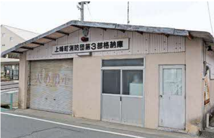
移転予定の第3部消防格納庫
