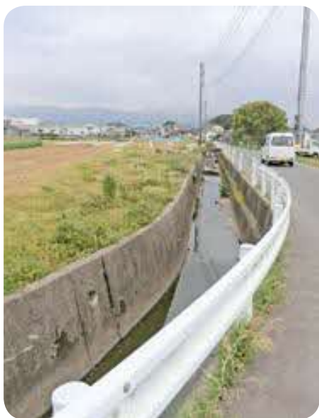
床板設置が望まれる米多坊所線水路
