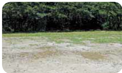
排水不良の上中グラウンド南側
