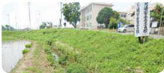
上小北側通学路沿い法面
