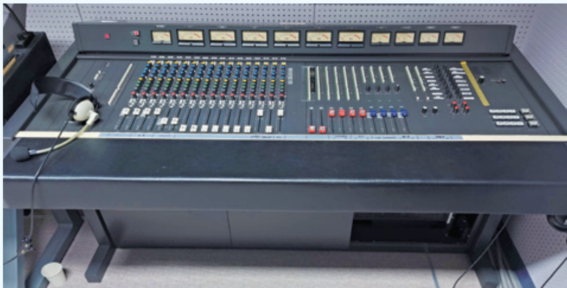
町民センターのミキサー
