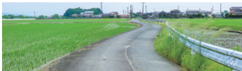
道路改良工事予定の町道八枚・碓線
