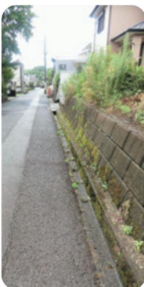
側溝改良（井手口地区）
