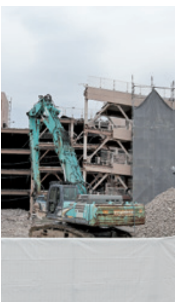
建屋解体の様子
