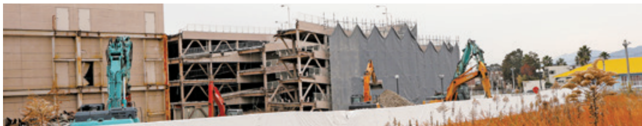
解体工事が始まった旧イオン
