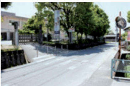
上峰小前の歩道では拡張工事が行われている
