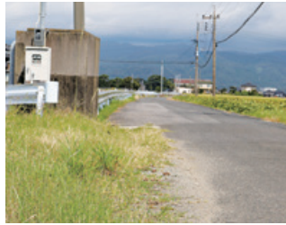
道路改良予定の町道八枚・碓線
